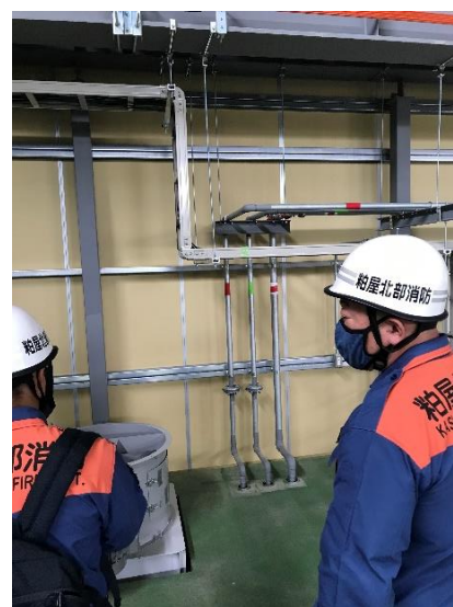
工場の消防検査
